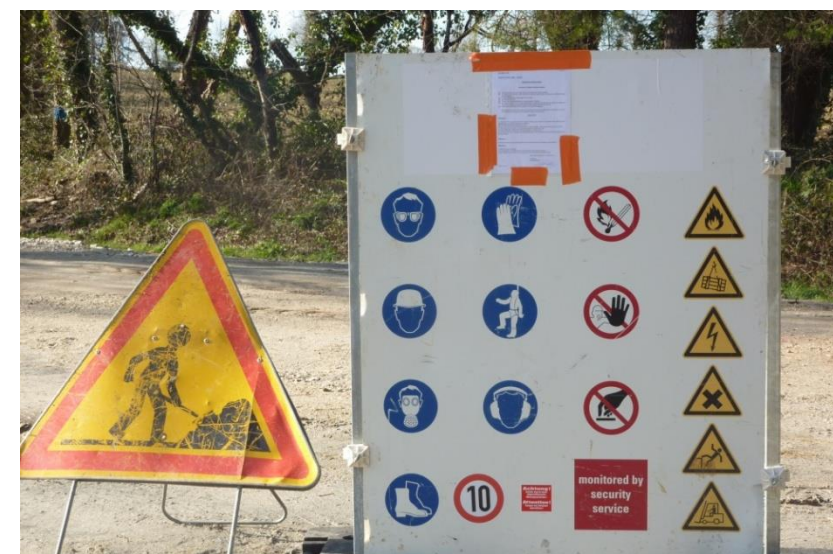
Figure 175. Sécurisation du chantier (Crédit photo : Quénéa Energies Renouvelables)
