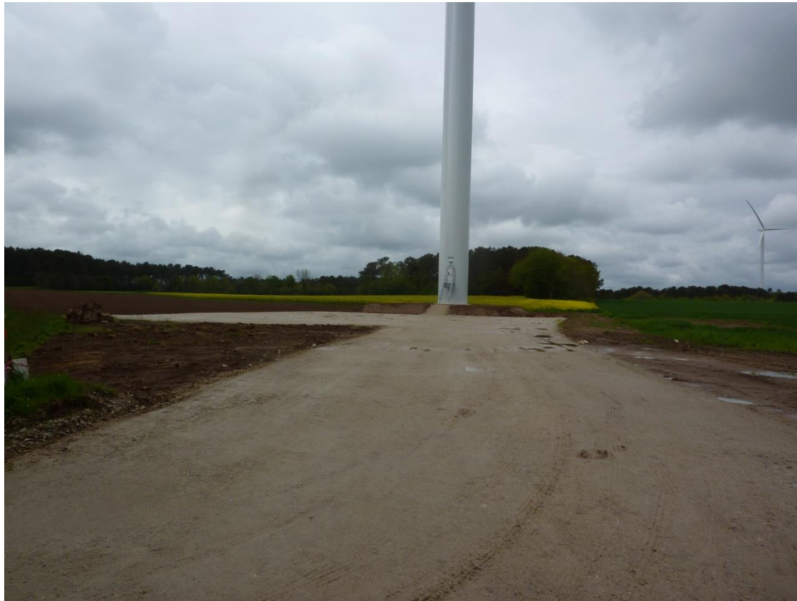
Figure 126. Plateforme permanente (Crédit photo : Quénéa Energies Renouvelables)
