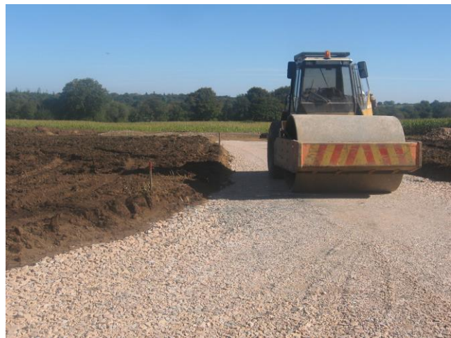
Figure 143. Terrassement des voies d'accès (Crédit photo : Quénéa)
