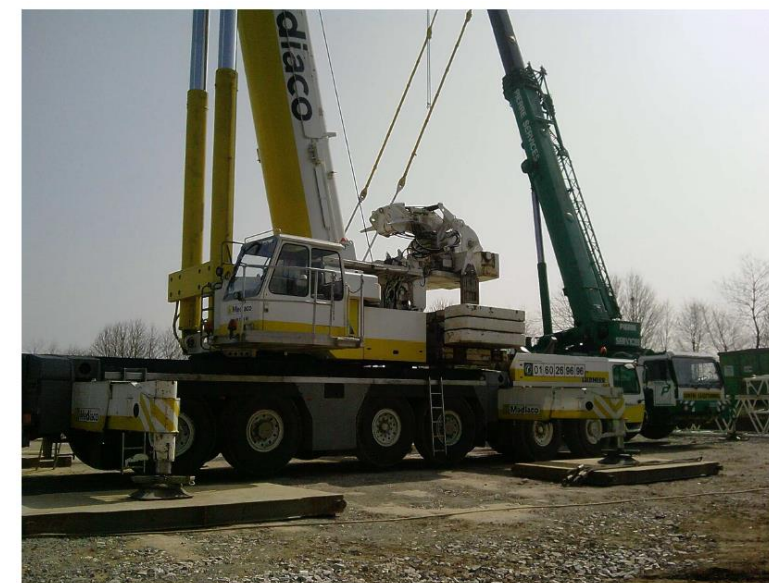
Figure 137 : Grue stabilisée (Crédit photo : Quénéa Energies Renouvelables)
