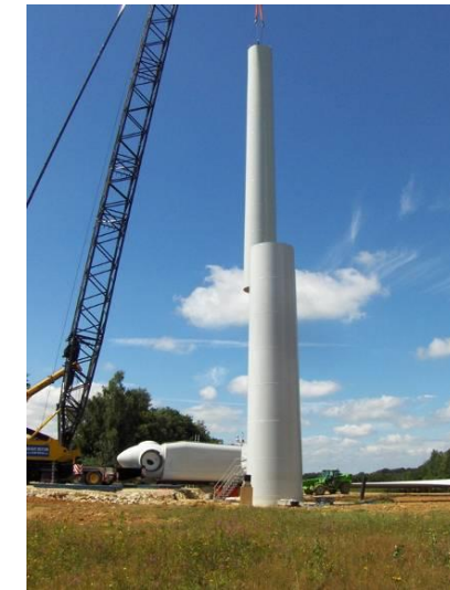
Figure 157 : Assemblage du mât
