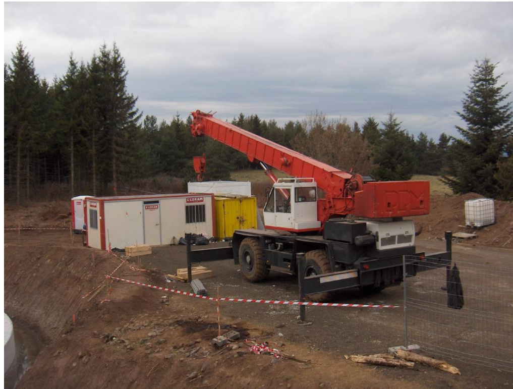
Figure 138. Mise en place d'une aire de cantonnement (Crédit photo : Quénéa Energies Renouvelables)
