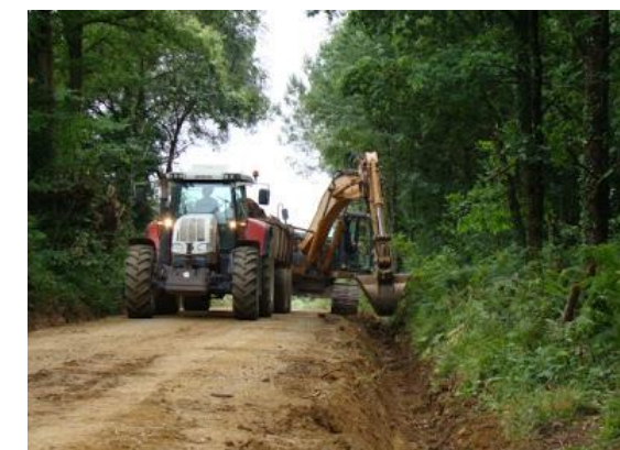
Figure 147. Création de nouveaux fossés de drainage (Crédit photo : Bégawatts)
