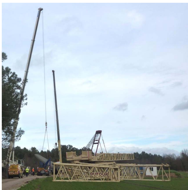
Figure 136: Assemblage de la grue (Crédit photo : Quénéa Energies Renouvelables)
