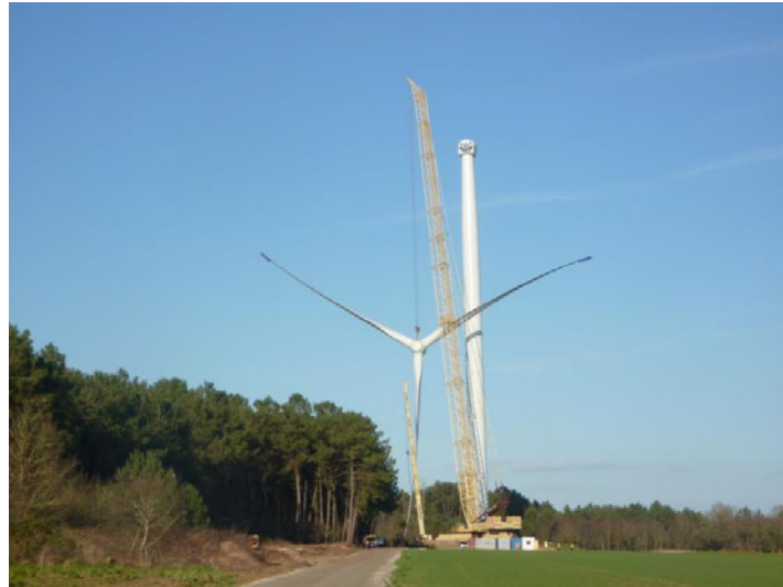
Figure 159 :. Montage du rotor et des pales (Crédit photo : Quénéa)
