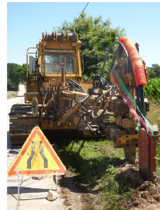
Figure 132 : Enfouissement de câbles – technique soc tracté
