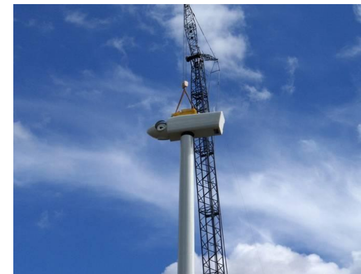
Figure 158 : Mise en place de la nacelle (Crédit photo : Vestas)
