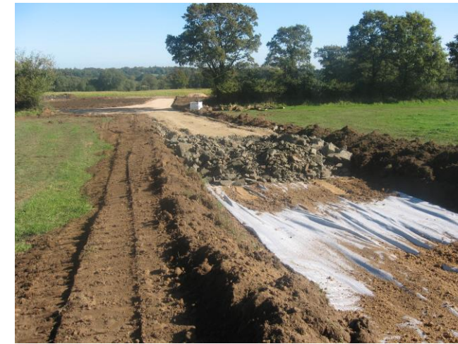
Figure 144. Construction des voies d'accès (Crédit photo : Quénéa)
