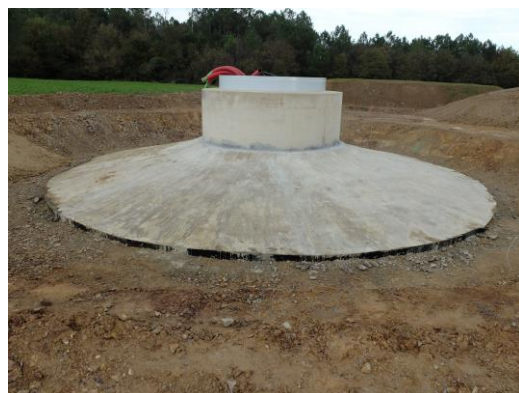
Figure 151. Bétonnage (Crédit photo : Quénéa)
