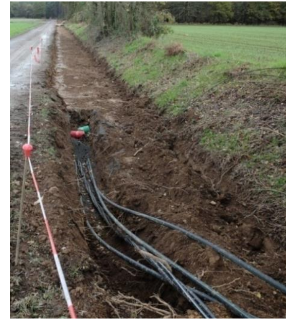
Figure 131. Enfouissement de câbles (Crédit photo : Quénéa)
