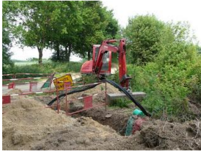
Figure 154. Travaux de passage de câble avec pelle mécanique
