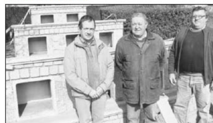
Jeudi, les élus sont allés voir l'avancement des travaux entrepris au cimetière. Il va être doté d'un nouveau columbarium de dix places, le précédent étant complet. Les travaux ont été confiés à l'entreprise de maçonnerie Le Brix, de Plumieux, pour un coût de 8.916 € TTC. D'autre part, la mise à jour et la gestion des emplacements du cimetière se feront à l'aide d'un logiciel, certains caveaux n'ayant plus de référent.
