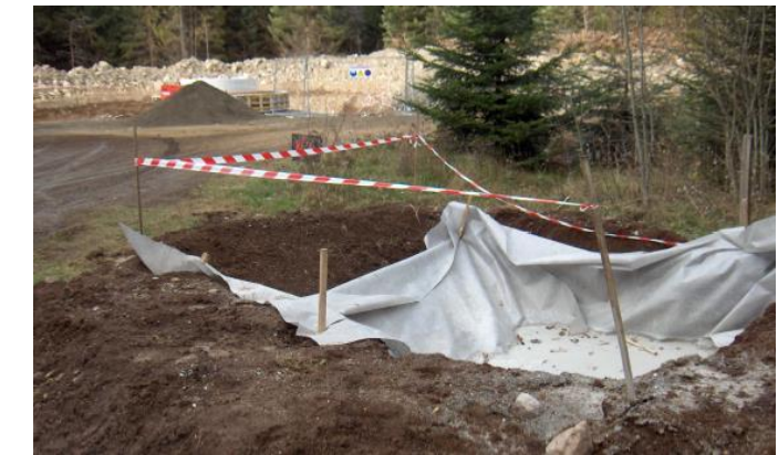
Figure 146. Excavation pour déchet (Crédit photo : Quénéa)
