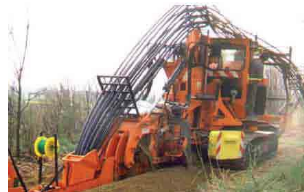
Figure 152. Travaux de passage de câble avec trancheuse
