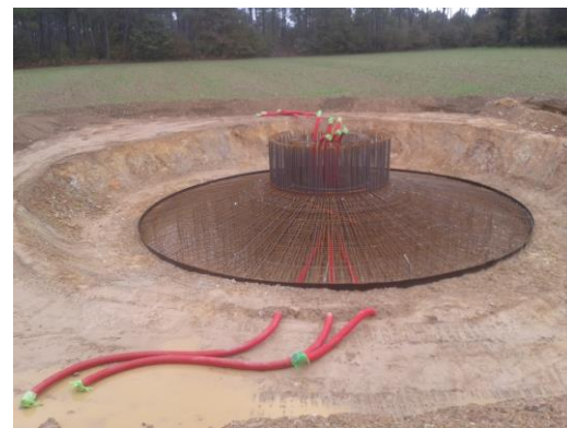
Figure 150. Ferrailage (Crédit photo : Quénéa)
