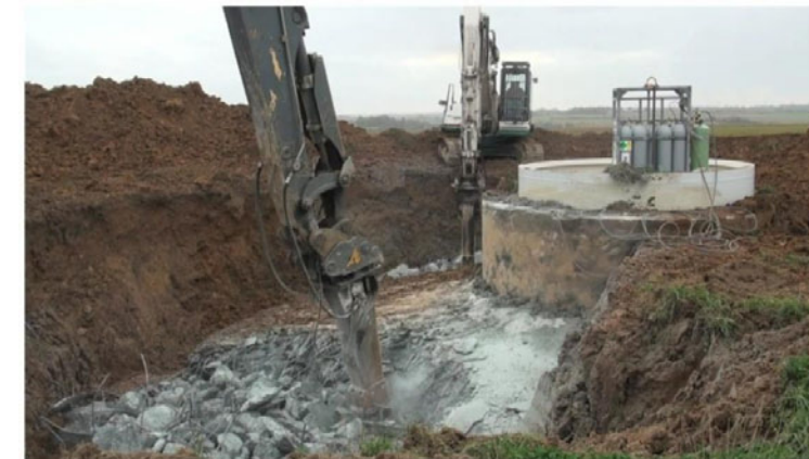
Figure 160. Démantèlement d'un parc éolien à Criel-sur-Mer (76) (Crédit photo : Société Valorem)
